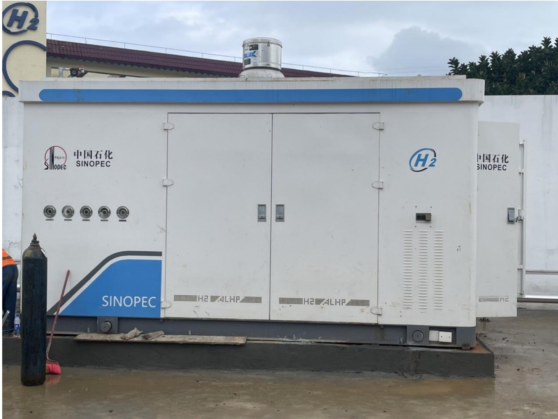
| 厚普90MPa氢能液驱压缩机 橇
